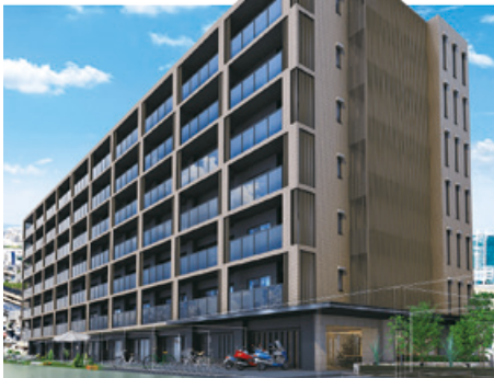
2024年5月 竣工予定 トラスト福岡空港レジデンス
