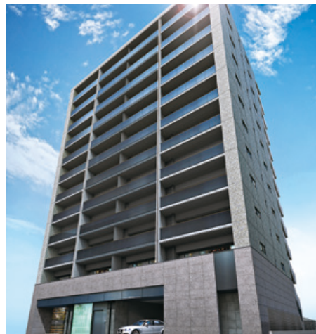
2024年9月 竣工予定 トラストレジデンス西鉄久留米駅
